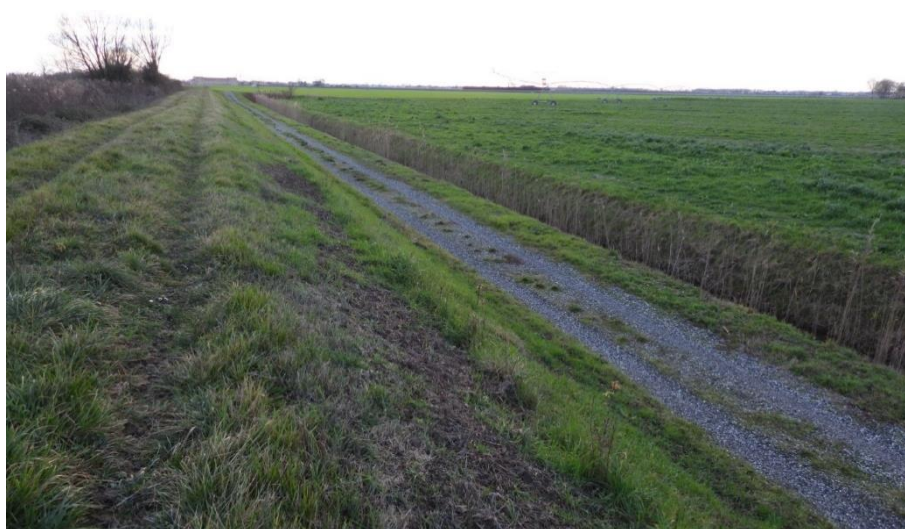
Figura 5: Pista ciclabile realizzata a piede d'argine esterno (2).
