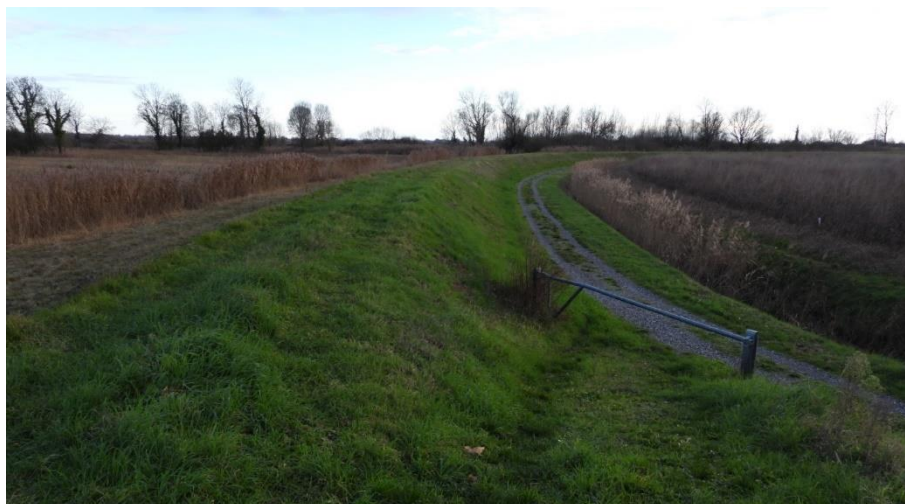
Figura 4: Pista ciclabile realizzata a piede d'argine esterno (1).
